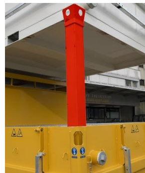
Abb. 20: Ausrichtung Stapelpfosten Waschfläche
