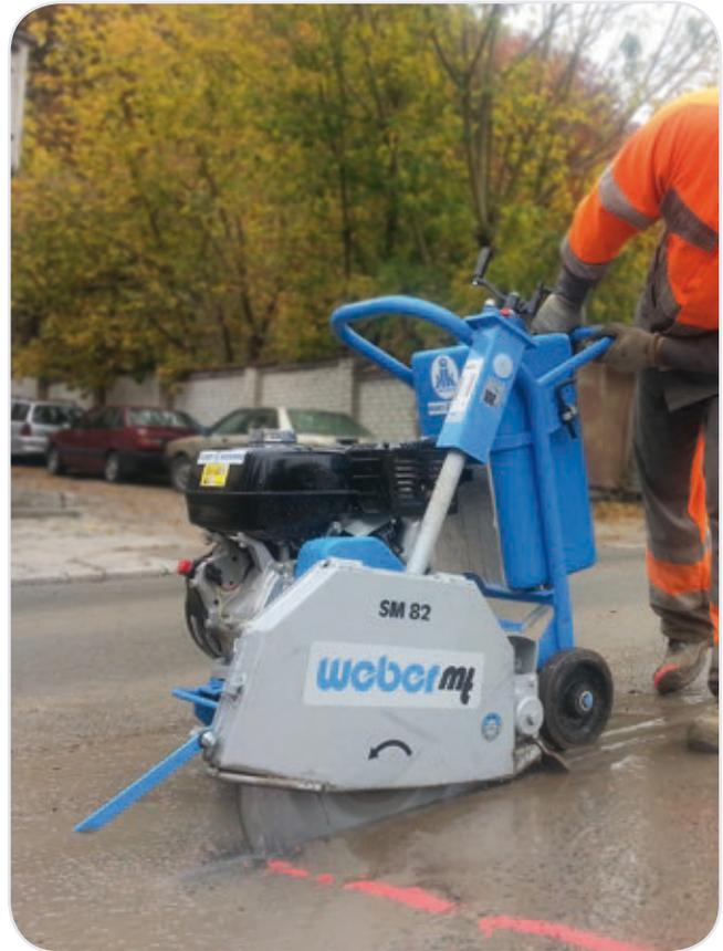
Fester Bestandteil der Weber MT Produktpalette sind Beton-Innenvibratoren in vielfältigen Ausführungen sowie die passenden Umformer dazu. Für Schneidarbeiten in Asphalt oder Beton gibt es die Fugenschneidmaschinen der SM-Baureihe.
