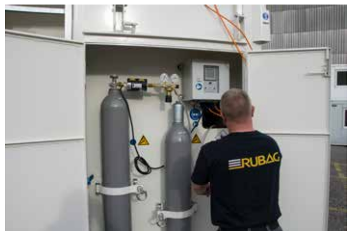
Der übersichtliche Materialschrank mit Doppeltüre bietet Platz für zwei Gasflaschen, Gasflaschenwaage, Alarmbox und Kleinmaterial
